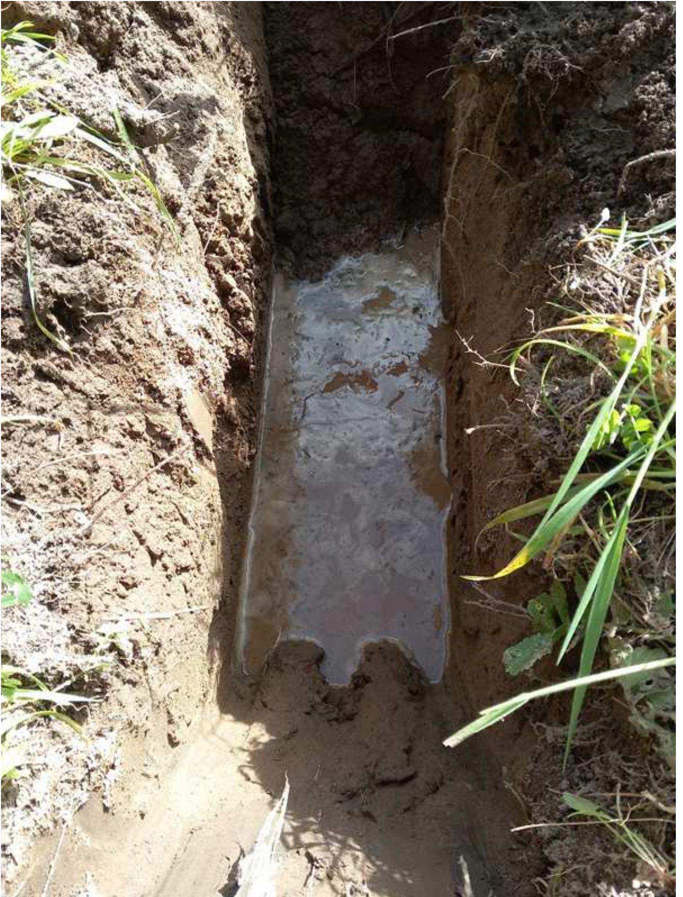
Photographie sondage 1 (niveau d'eau non stabilisé à -60cm/TN)
